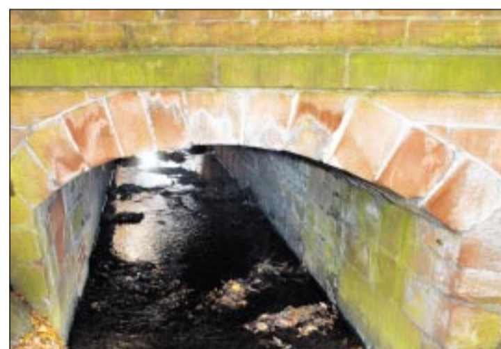
Versteckt hinter Beton: Unterhalb des sogenannten Breslauer Platzes liegt eine der ältesten Darmbachbrücken.
