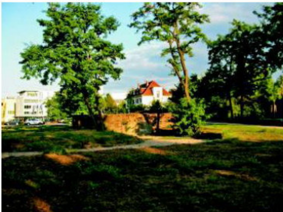
Aus dem 19. Jahrhundert: Darmstadts älteste Eisenbahnbrücke - auch hier wird sich der Darmbach bald wieder in seinem historischen Verlauf zeigen. Foto: Stadt Darmstadt / Straßenverkehrs- und Tiefbauamt
